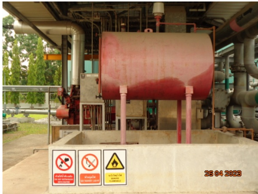
รูปที่ 50 ถังเก็บน้ำมันดีเซล สำหรับจ่ายให้กับ Fire Pump
