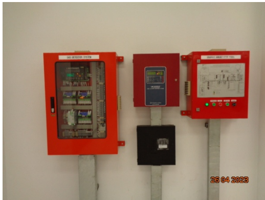
รูปที่ 28 Gas Detector System
