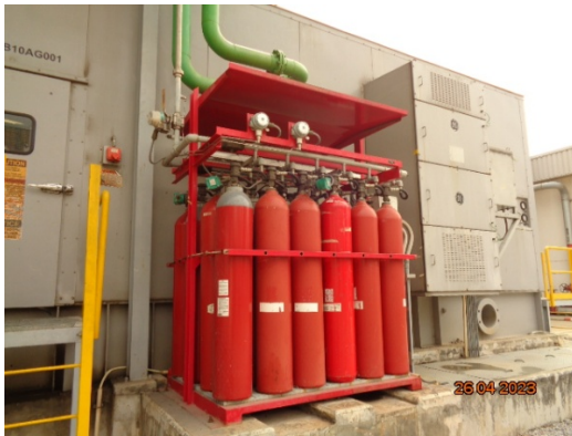
รูปที่ 44 ระบบดับเพลิงแบบใช้ CO 2
