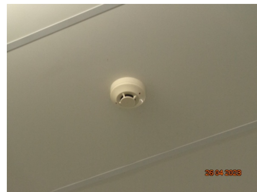
รูปที่ 31 Smoke Detectors
