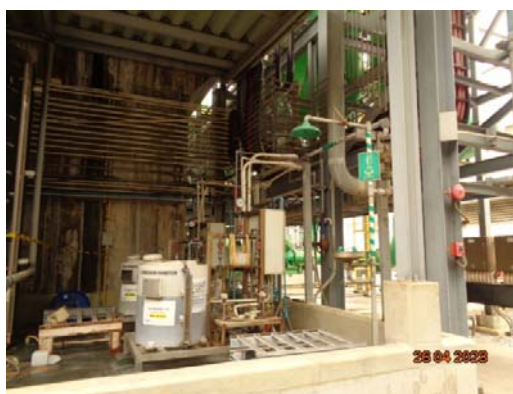
รูปที่ 53 อ่างล้างตาฉุกเฉิน และฝักบัวชำระล้างร่างกาย
