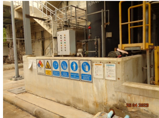
รูปที่ 54 กำแพงคอนกรีตล้อมรอบถังน้ำมันและสารเคมี
