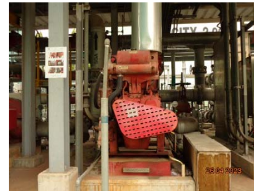
รูปที่ 49 ระบบน้ำดับเพลิงที่ใช้เครื่องยนต์ (Fire Pump)
