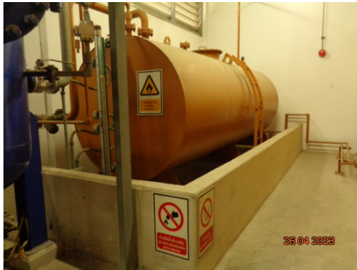
รูปที่ 54 กำแพงคอนกรีตล้อมรอบถังน้ำมันและสารเคมี
