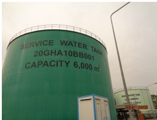
รูปที่ 46 ถังเก็บกักน้ำประปาขนาด 6,000 ลูกบาศก์เมตร
